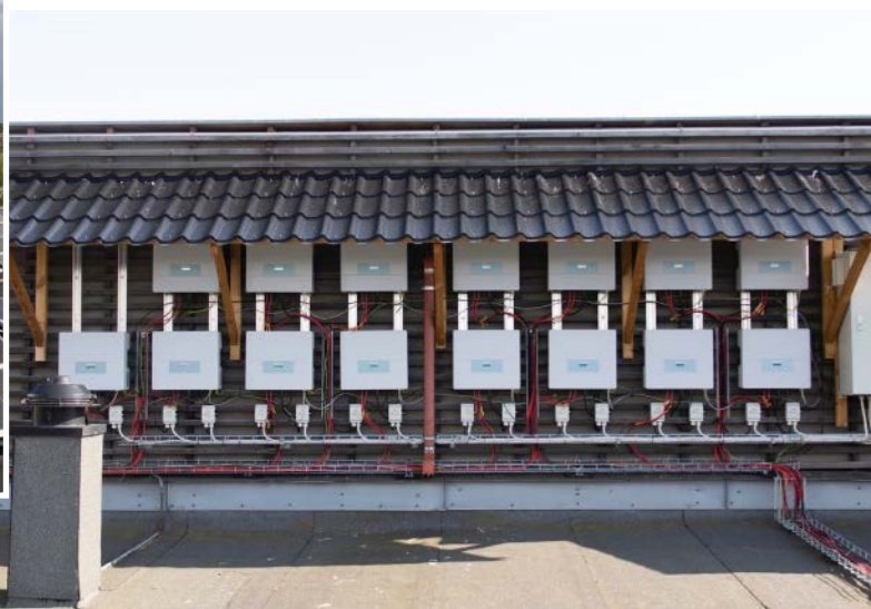
奥斯陆的Tveita Senter购物中心安装15台的台达H5A太阳能变流器
