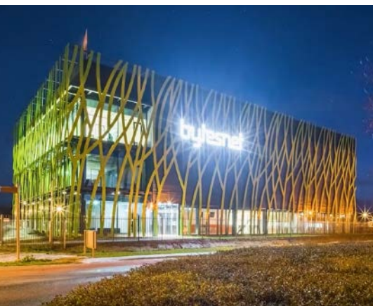
台达UPS和DCIM解决方案为Bytesnet提供全新的绿色机房和数据实验室
