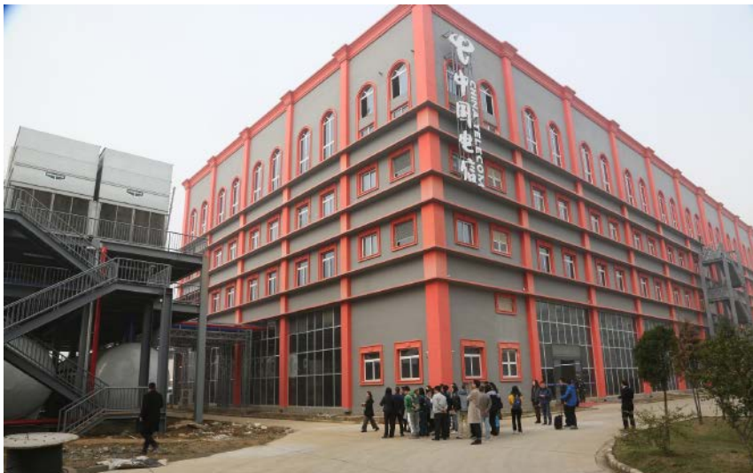
台达组织近30家媒体参访武汉临空港数据基地一期项目，以专业眼光见证华中最大国际5A级IDC
