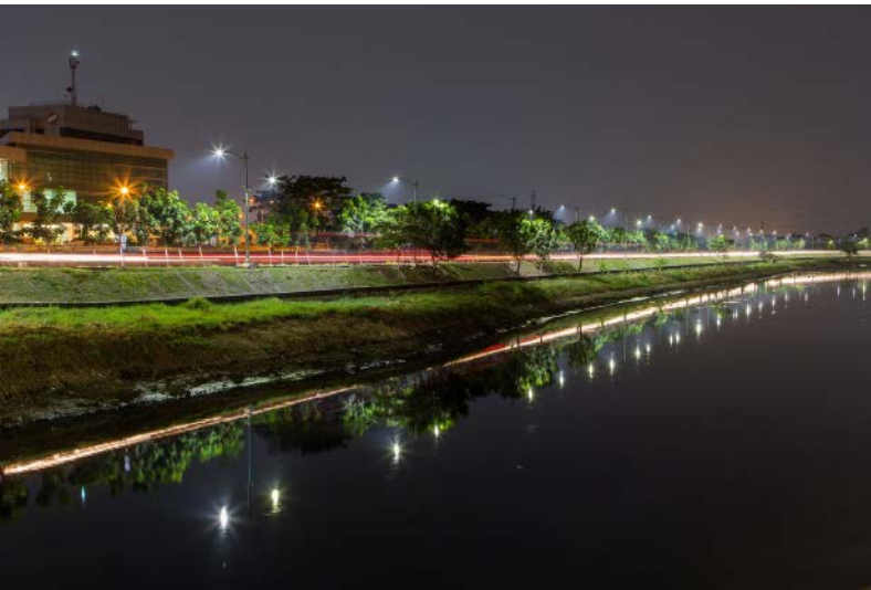
在BANJIR KANAL TIMUR的河边道路安装台达智慧路灯，行车更加安全
