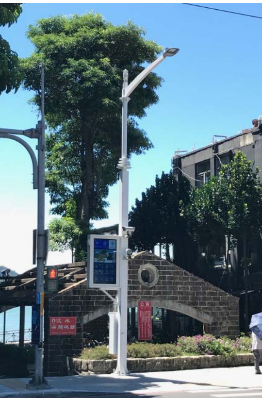
台达智慧路灯解决方案提供环境感测，搜集市内全天量测温湿度、风向、风速等信息，可用来智能调控路灯亮度
