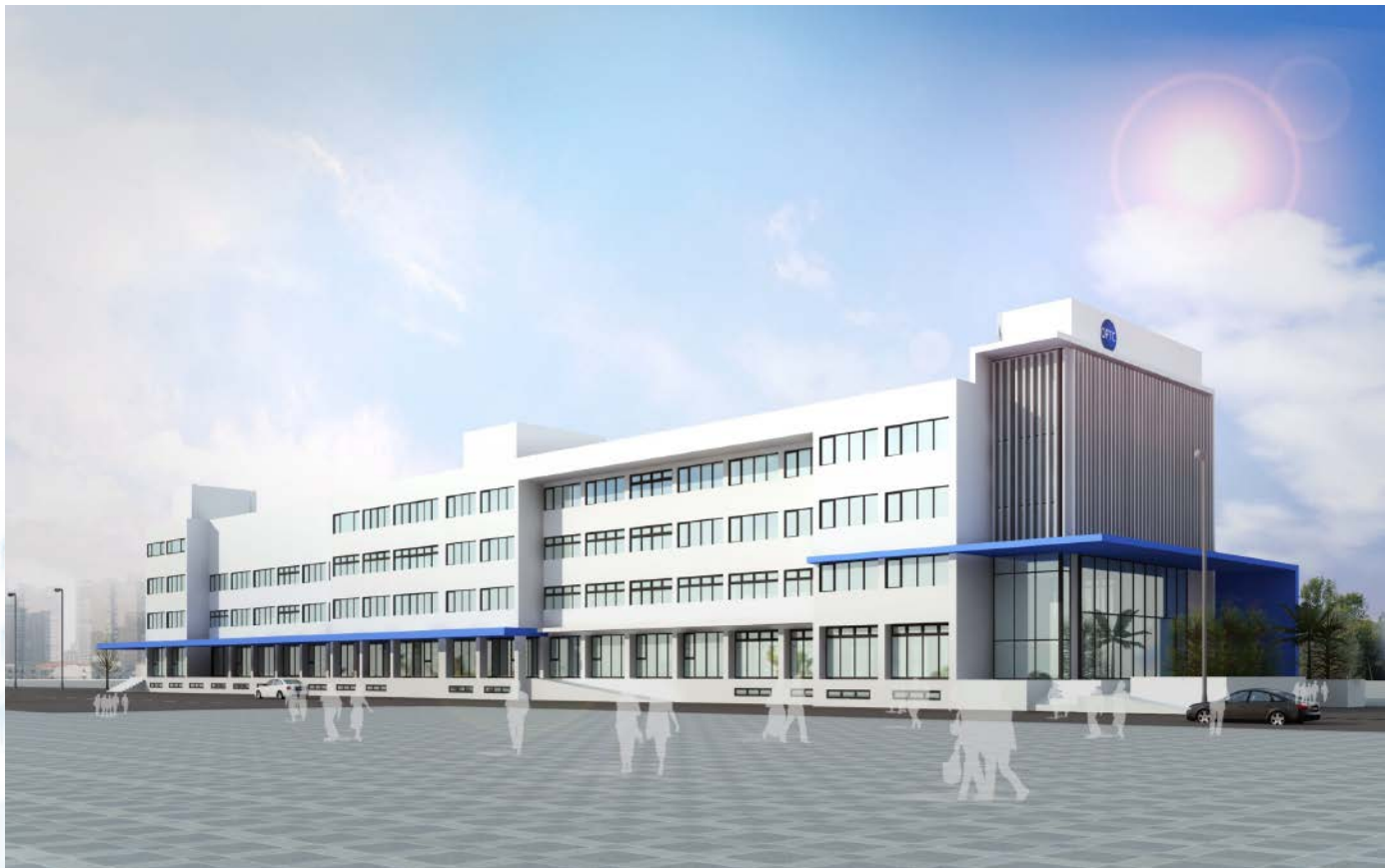
台达楼宇自动化解决方案为亚东石化打造智能安全、节能舒适的办公大楼
