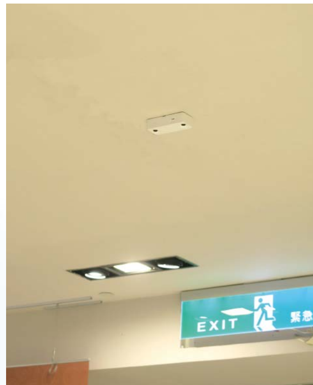
VIVOTEK人流计数摄影机透过双镜头及3D景深技术，人流计算精确度可达98%
