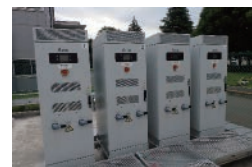
功率调节器：125kW x 4 units 储能系统：331kWh
