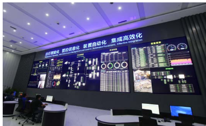
台達為東嶽集團打造了三套單屏67英寸，共計56塊的DLP大螢幕拼接顯示系統
