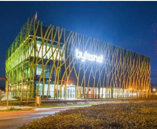
台達UPS和DCIM解決方案為Bytesnet提供全新的綠色機房和資料實驗室
