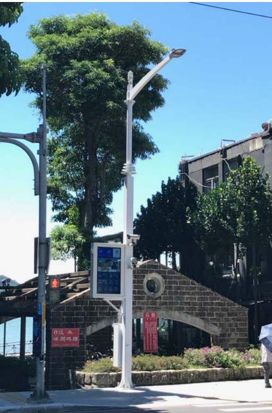
台達智慧路燈解決方案提供環境感測，蒐集市內全天候測溫濕度、風向、風速等資訊，可用來智慧調控路燈亮度
