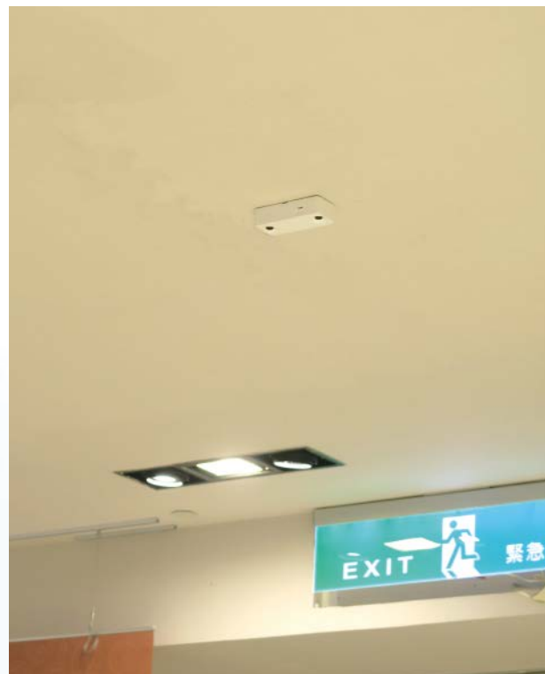
VIVOTEK人流計數攝影機透過雙鏡頭及3D景深技術，人流計算精確度可達98%
