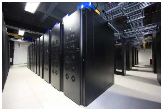
通过采用背板空调、整机房全母线设计，台达打造的这座新IDC比传统方案多安装50面机柜
