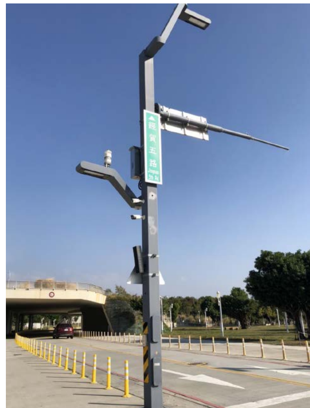
台达智能路灯解决方案结合节能照明、物联装置及资通讯科技，提供道路照明以外的创新增值服务
