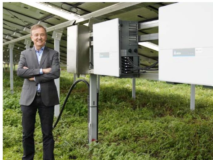
Schornhof太阳能园区安装了超过1,500颗台达M70A逆变器
