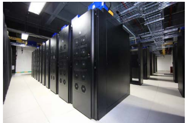
通過採用背板空調、整機房全母線設計，台達打造的這座新IDC比傳統方案多安裝50面機櫃
