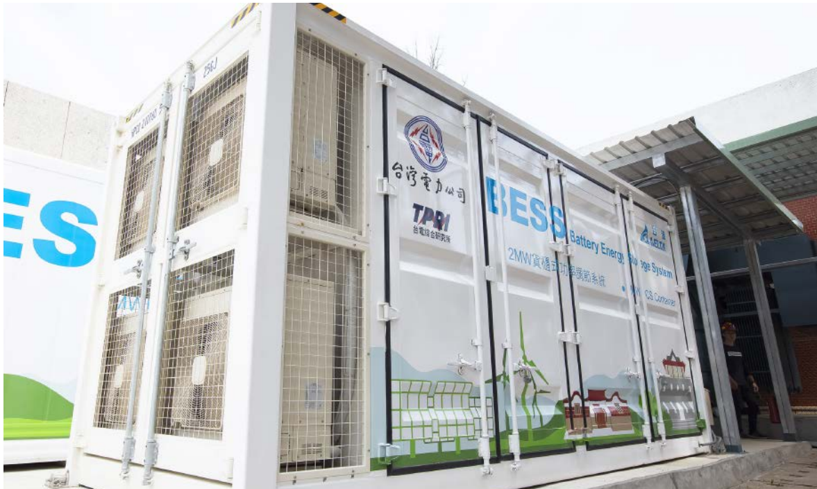
台達提供PCS貨櫃與鋰電池儲能貨櫃 (BESS)，並透過儲能管理系統 (BEMS) 及周邊電力裝置，整合而成的一站式儲能解決方案
