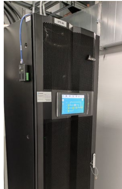
台達Modulon DPH系列500kVA UPS系統精進俄羅斯資料中心現代化
